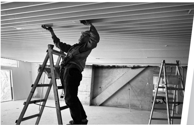
安装室内照明灯具
