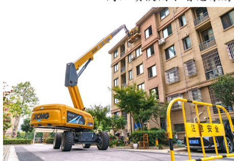
高品质饮用水项目外立管施工
