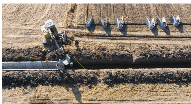
当前正值冬修水利黄金期。近日,在广陈镇曹港村,施工人员在田间修建沟渠,为明年的粮食安全、农业增效打下坚实基础。
