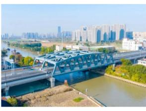
平湖至安吉公路平湖新仓至曹桥段工程(以下简称“S302平湖段”)是我市接轨上海、补齐平湖东西方向主干路网的重要项目。其中，六里塘大桥是S302平湖段中的一座改建大桥，也是该项目的“最后一段”，从大桥主墩浇筑到主桥钢桁梁吊装再到完成桥面混凝土铺装、沥青路面摊铺，交投集团克服连续降雨、交叉施工、工期紧张等重重困难，争分夺秒抢进度，全力以赴抓落实，最终在去年8月实现六里塘大桥正式通车，推动S302平湖段全线通车，有效填补了中部贯通东西走廊高等级公路的空白，缩短了与上海的时空距离，为区域经济发展带来新机遇。
