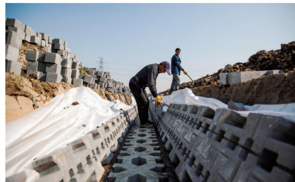
近日,在新仓镇稻田退水“零直排”杉青港村北片项目现场,工人们在沟渠施工中。该项目通过节水减排、生态沟渠等工程,对5805亩稻田进行综合系统治理。项目投入使用后,化肥减量93%以上,氨氮减排30%以上,进一步减少农业面源污染。
