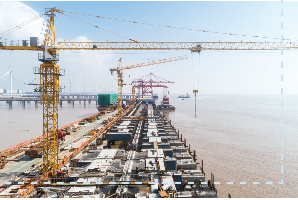
施工人员在対水域栈桥进行铺设
