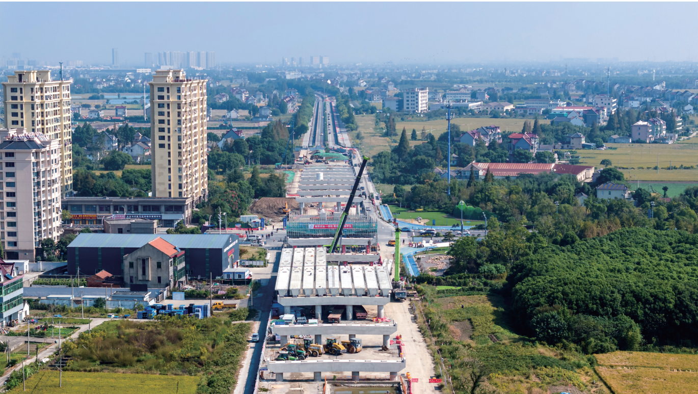
近日,在228国道平湖独山至林埭段改扩建工程现场,30米箱梁已陆续进行架设,桥梁上部结构进入全面施工阶段。据了解,该工程主线起于浙沪交界处,路线沿现状228国道向西,终点位于林埭镇与乍浦镇交界处附近,项目建成后将有效提升228国道通行速度,更好实现其疏港功能。
