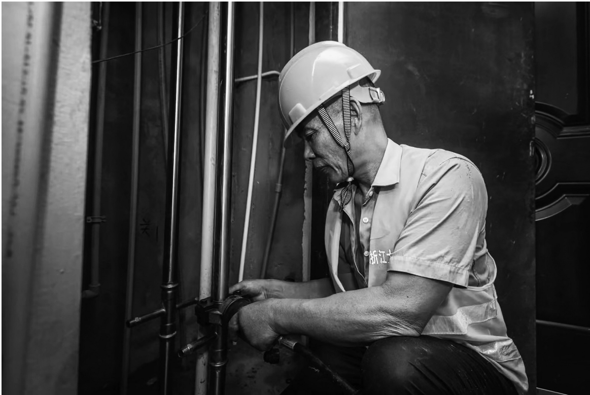
近日，在当湖街道嘉和花苑小区，市水务集团的工作人员在对给水立管材质进行改造提升。据悉，此次项目通过对居民原管道立管、水表、阀门等设备进行更新，进一步提升居民用水品质。
