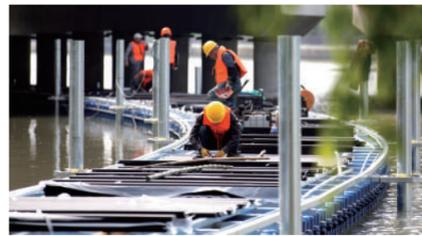
日前,在东湖南岸,施工人员在为浮桥搭建护栏。该浮桥为案山桥下绿道贯通项目之一,建成后将连接东湖未来社区沿河浮桥,打通环线绿道。 ■摄影 王强
