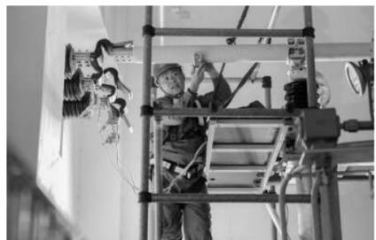
近日，市供电公司运维检修中心全业务核心班组顺利完成110千伏塘桥变电站1号主变全绝缘管母大修作业，大大提升了平湖主城区电网安全稳定运行性能，提前为本地电网迎峰度夏工作打下坚实基础。
