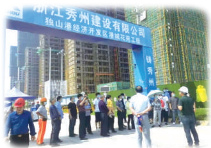
视察安置房项目建设情况
