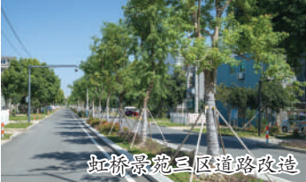
虹桥景苑三区道路改造
