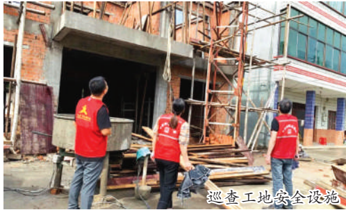
巡查工地安全设施
