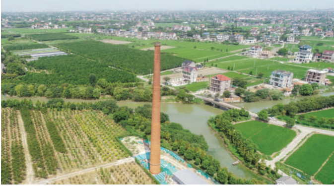
曹桥街道孔家堰村丁店窑厂整治
