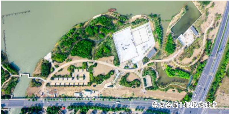
东方公园Ⅰ标段建设中
