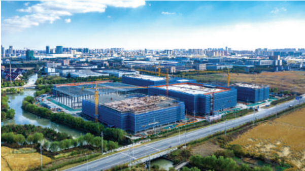
智能装备产业园（樱园）建设快速推进
