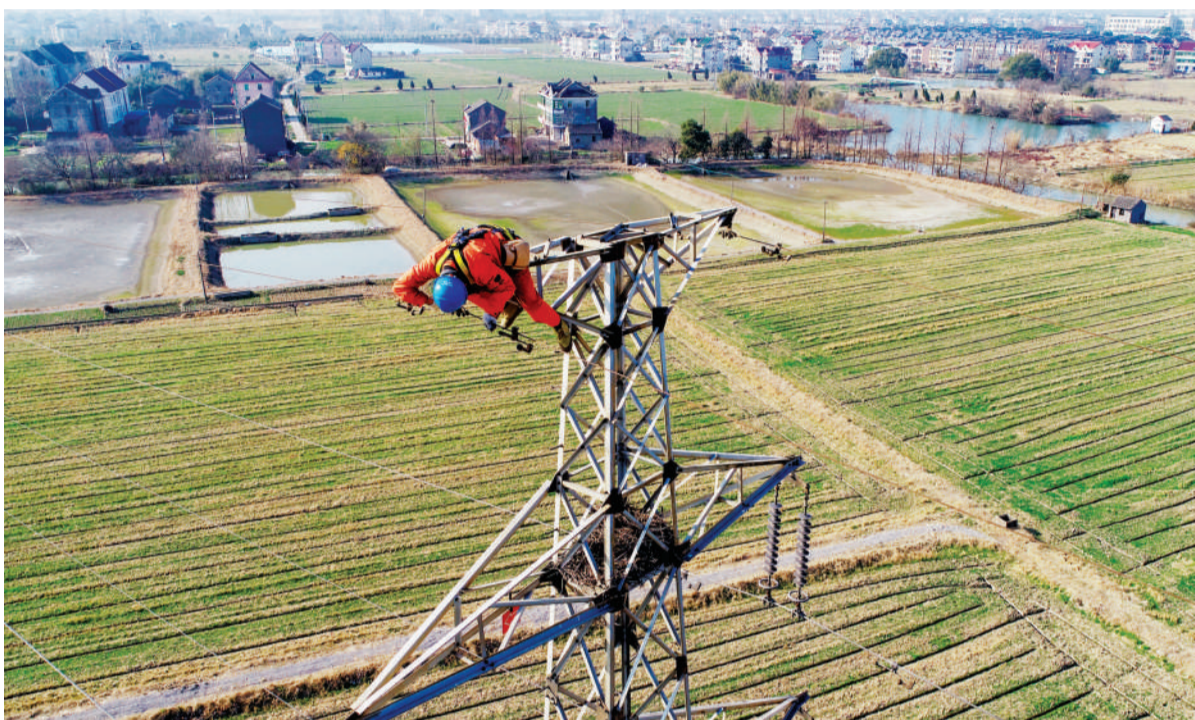
高空巡检 保障春节用电
