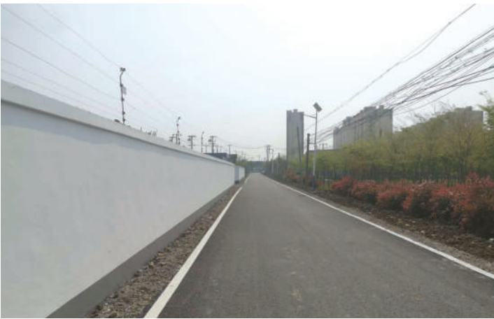
改造前后的新仓镇农村公路
