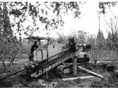
近日，在新埭镇星光村一自然村落保护点，施工人员正在安装污水主管道。该地去年经过全域秀美打造，村落环境大为提升。今年启动的农村污水治理工程，进一步提升村民的居住环境。
