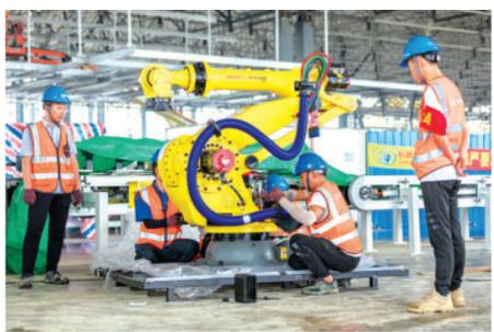
长城整车项目焊装车间首批自动化设备安装
