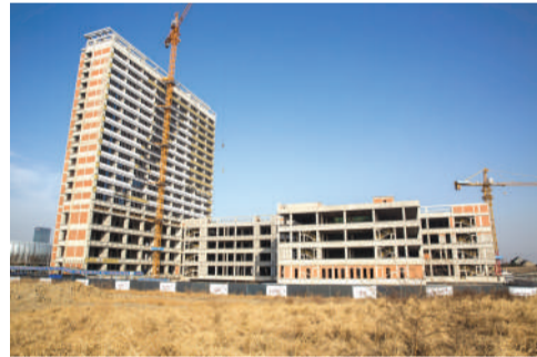
中医院迁建工程
