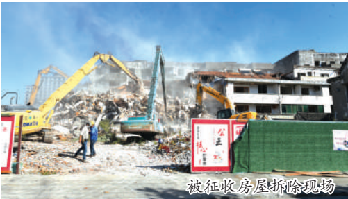
被征收房屋拆除现场
