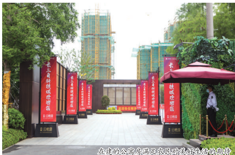
在建的公寓房满足农民对美好生活的期待
