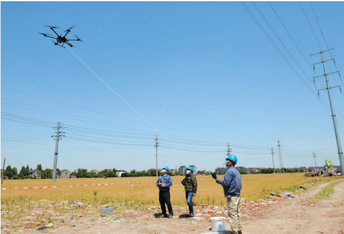
无人机“空中架线” 近日,在钟埭园区110千伏变电站进线优化工程的施工现场,一架无人机拖拽着导引绳进行空中架线作业。市供电公司今年首次运用无人机完成空中架线作业,不仅降低了电力线路铺设工程作业时的经济成本,工作效率也至少提高了5倍。■摄影 王 强 沈文文 马旭辉
