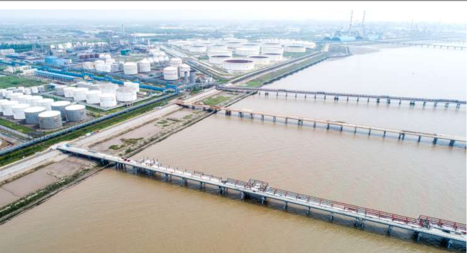
近日,独山港区a3、a4化工码头正抓紧建设中。据介绍,今年1至4月,独山港区货物吞吐量同比增长37.7%,随着新港口建设和公共配套建设的推进,将进一步助推港产城融合发展,满足进口原材料运输需求。
