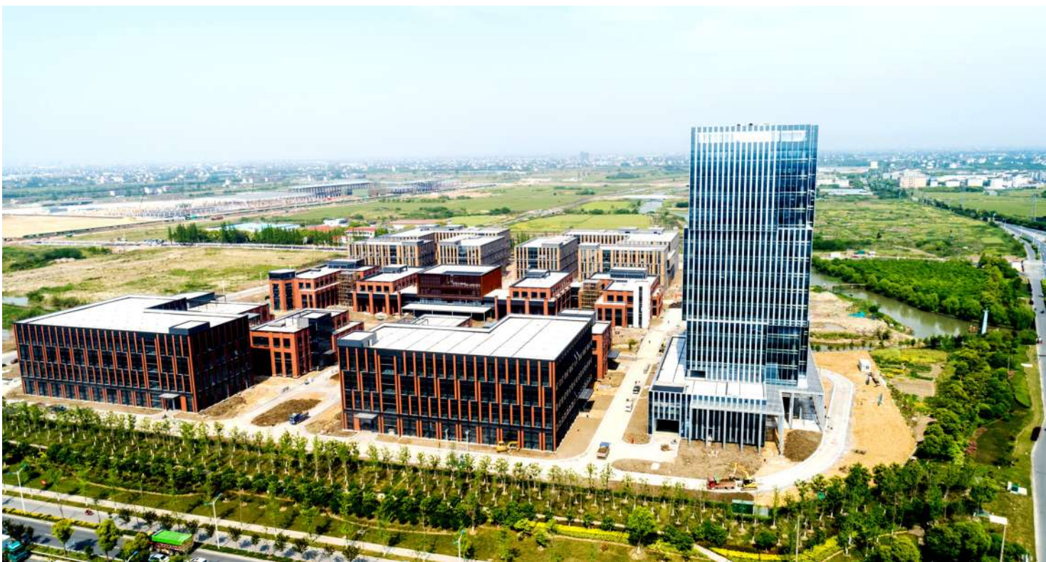
智创园主体完工
