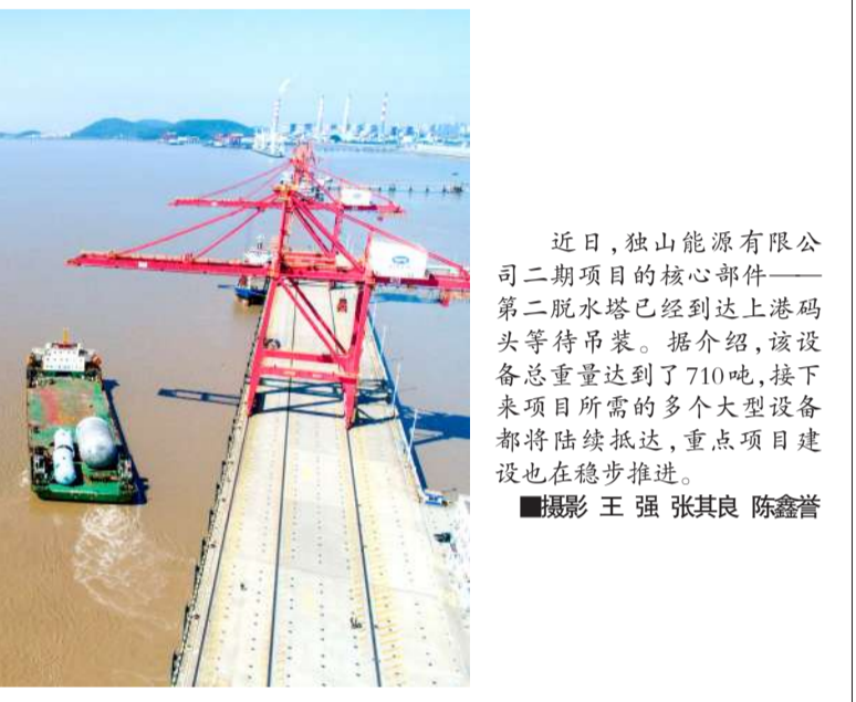
近日,独山能源有限公司二期项目的核心部件——第二脱水塔已经到达上港码头等待吊装。据介绍,该设备总重量达到了710吨,接下来项目所需的多个大型设备都将陆续抵达,重点项目建设也在稳步推进。
